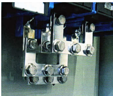
شکل ۱۷،۲- اتصالات کابل
